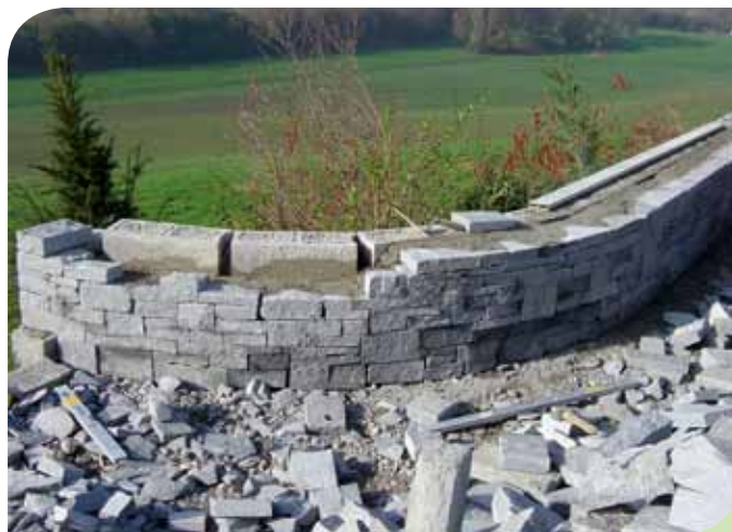
Herausforderung Schweizer Hausgarten: Eine steile Böschung wurde mit Schalungssteinen abgefangen und die Mauer mit Granit verkleidet.
